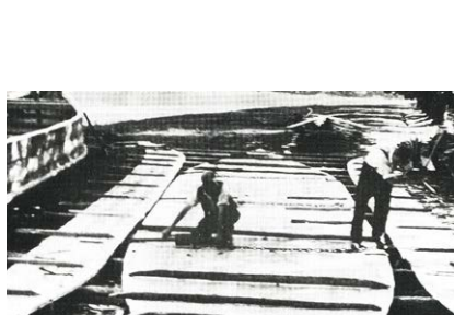
Schopper-Schiffbau: der Boden und die Seitenteile sind montiert. (Foto: Innmuseum Rosenheim)
