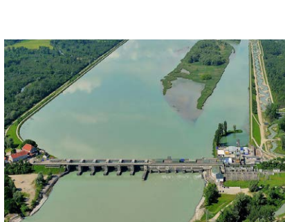
Das Kraftwerk Ering-Frauenstein von oben gesehen. (Foto: Siegfried Kerscher)
