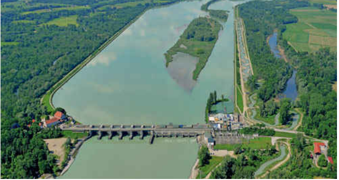
Das Kraftwerk Ering-Frauenstein. Der breite und hohe Stausee im Oberlauf ist hier gut zu erkennen.
