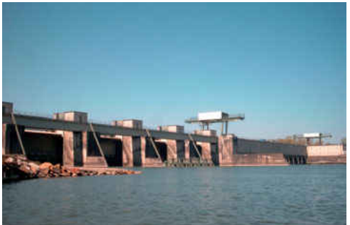
Kraftwerk Egglfing/ Oberberg
